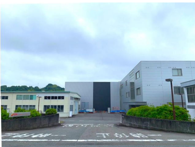
シミュレータ棟全景写真
